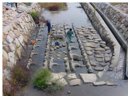
写真-1 魚道部全景 岡山県・砂川
