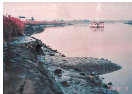
写真-1 原型を留めている荒籠 1)
