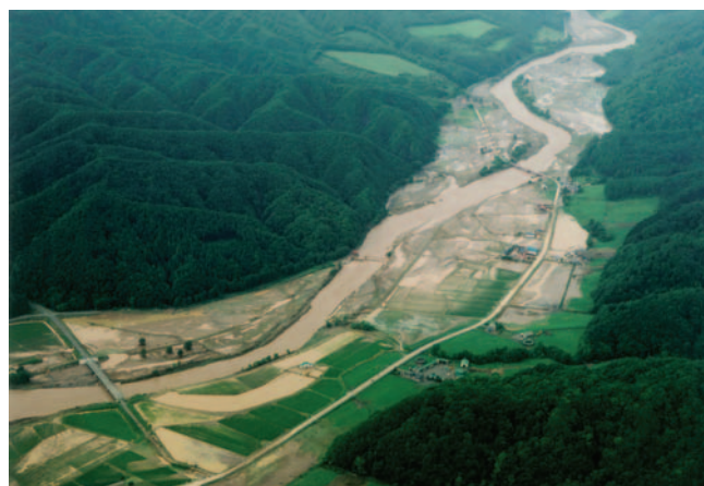
写真-1 調査対象区間上流側の被災状況 (KP8.4~12.2区間)
