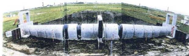
写真-5 柔構造樋門
