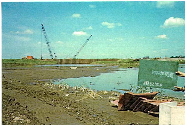
写真-1 A川左岸堤防の破堤状況
