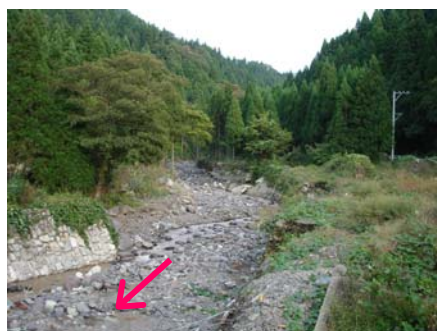
写真-1 ①上流河岸の樹木繁茂状況
