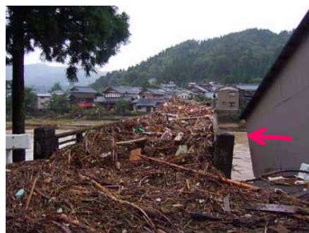
写真-6 ⑥大久保橋の流木状況 *1)
