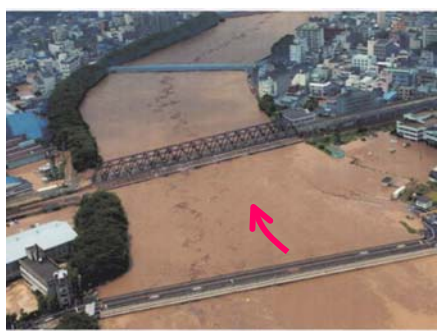
写真-11 ⑩木田橋付近の流木状況 *3)
