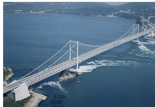
写真－1 大鳴門橋
