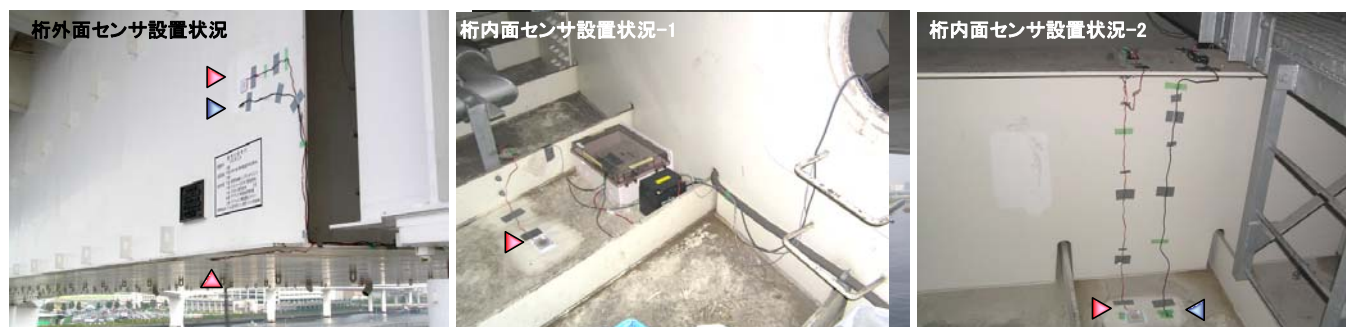
図-2 腐食環境調査各センサ設置状況
