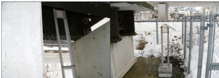
図 2 桁内外飛来塩分測定状況
