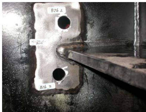
写真-2 ストップホール施工
