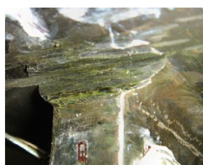
溶接部除去後
