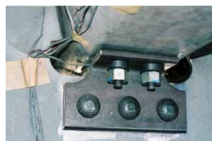
写真-2 対策工の実施状況
