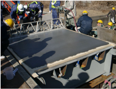
図-3 ゴムラテックスモルタルの施工
