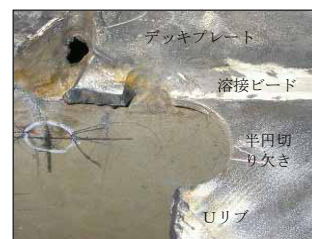
(b) Uリブ切断面の処理
