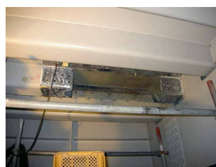
(a) 損傷Uリブ切除
