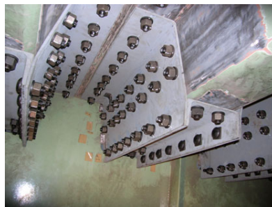
写真-3 施工完了
