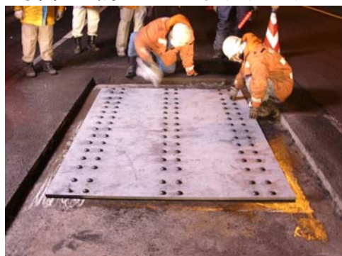
写真-5 応急板施工状況
