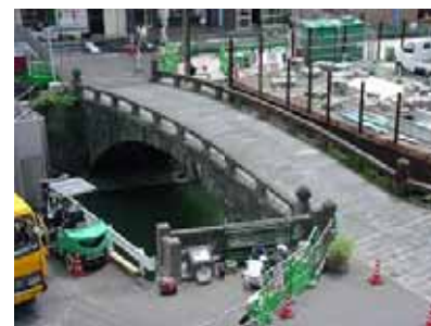
写真 - 1 袋橋全景
