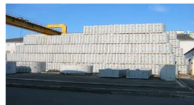
写真-1 セグメントストック状況
