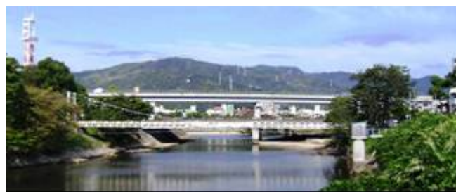
図3 計測橋梁(工兵橋，広島市)
