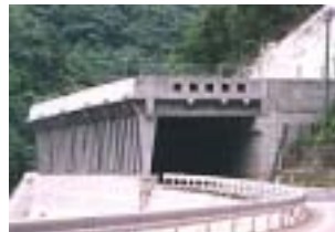
写真-1 ロックシェッド
