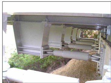
写真-2 制振装置の設置状況
