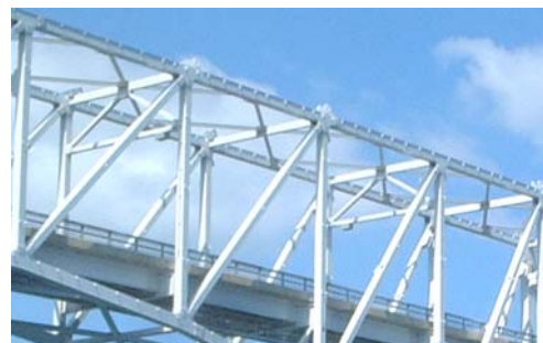
写真-1 対傾構の部材の状況
