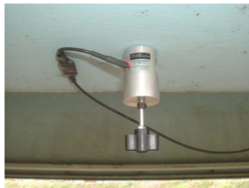
写真-1 設置状況
