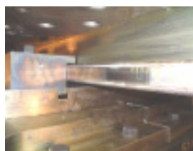
写真-6 上沓側面(SUS板)
