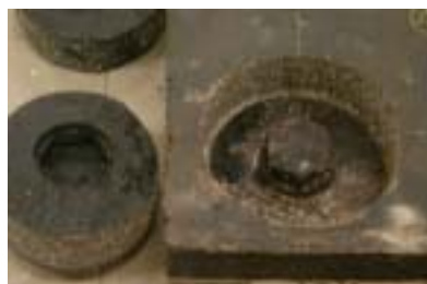
図-4 ボルト周りの充填状況
