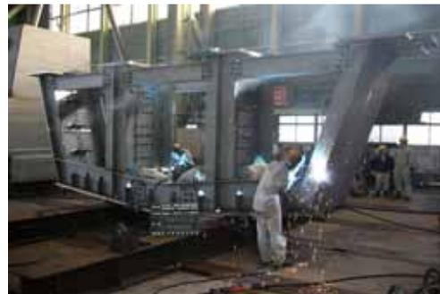
写真 - 1 溶接施工試験体
