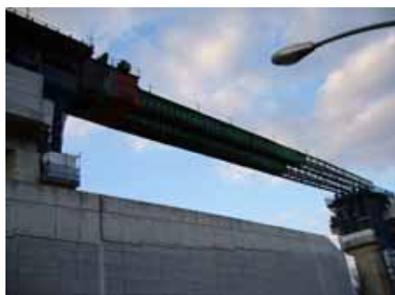
写真 - 2 送り出し工
