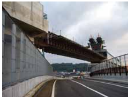
写真 - 3 降下工終了
