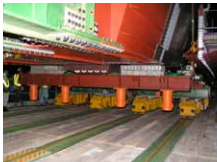
写真 - 1 盛り替えジャッキ、自走台車
