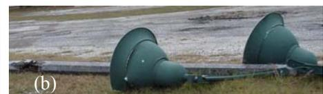
写真8 照明柱の倒壊
