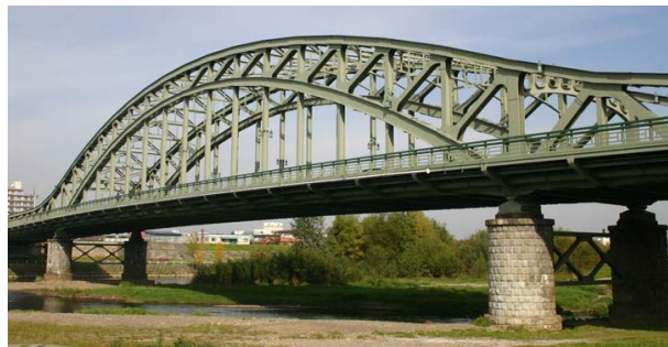
写真-1 旭橋の現況写真（主橋梁区間）
