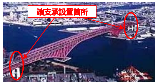
写真-1 港大橋全景
