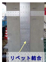
写真-5 リベット結合箇所
