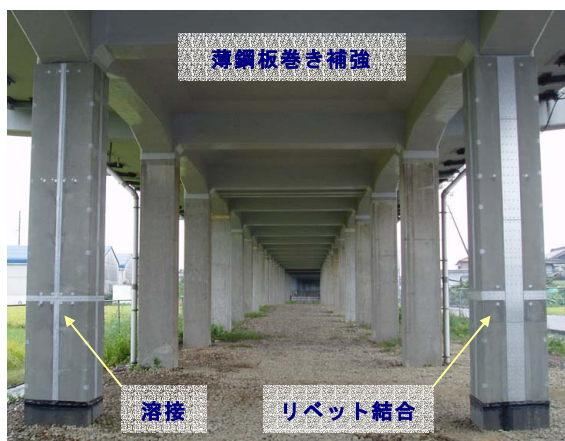
写真-6 試験施工状況
