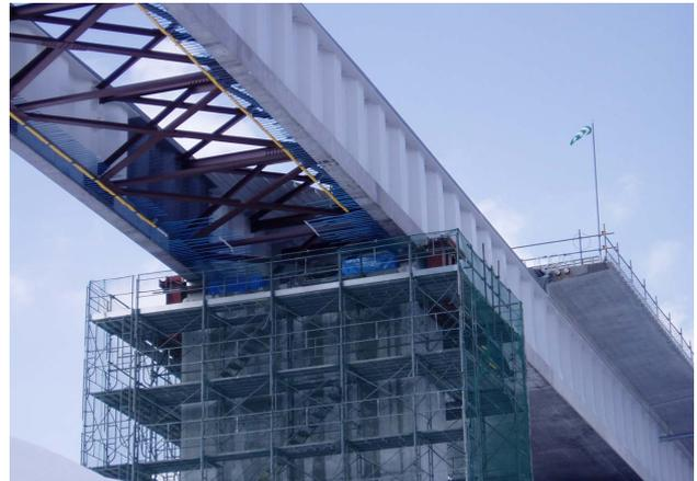
図-3 押出し架設状況
