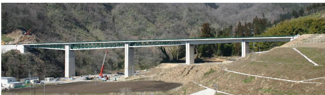
写真-2 施工状況（平成17年3月）
