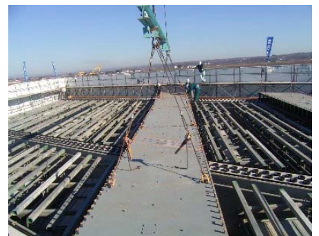
写真-1 頂版架設状況
