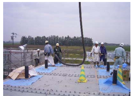
写真-2 コンクリート打設状況
