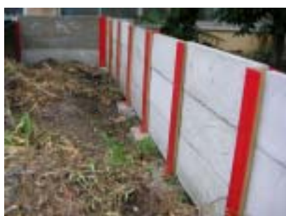
写真5 堆肥置き場完成
