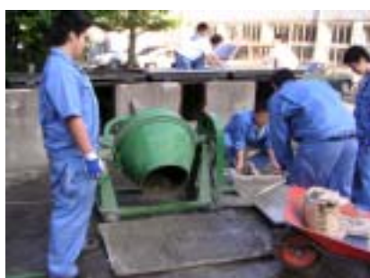
写真4 堆肥置き場施工
