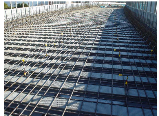
写真-1 突起付き T 形鋼ジベル合成床版 (配筋完了時)
