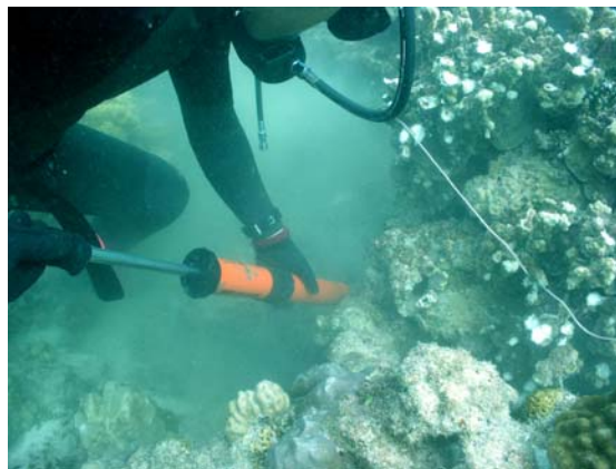
写真2 モルタルガンによる水中コンクリートの打設
