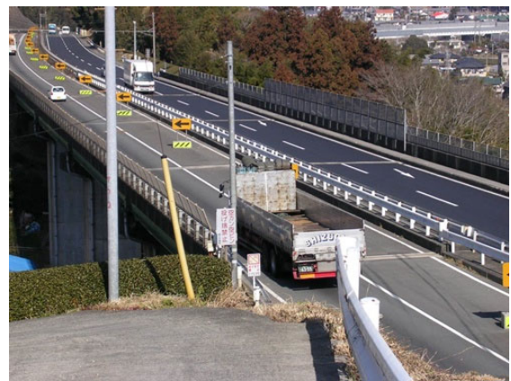
写真1 対象橋梁（第1志戸呂橋）
