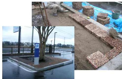
図 3. 国土交通省東北地方整備局能代河川 国道事務所での施工
