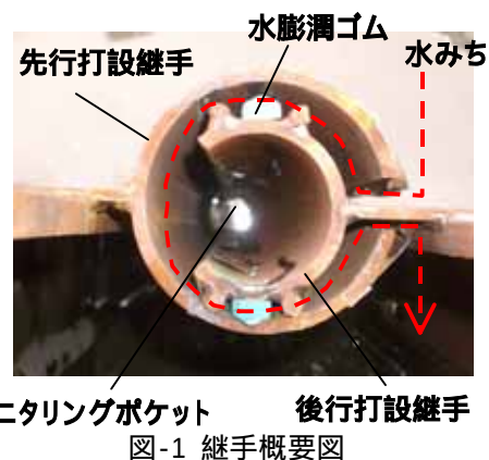
図-1 継手概要図
