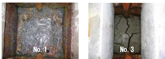
写真-3 実験後の粘土天端状況 (水を抜いた後撮影)
