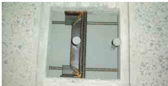
写真6 HPCa スラブ落盤防止装置
