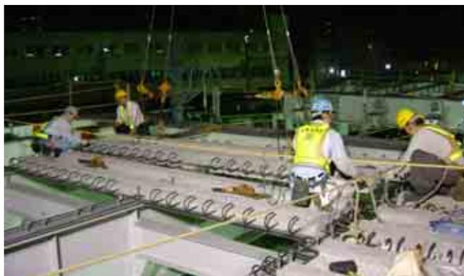
写真3 HPCa スラブ架設状況
