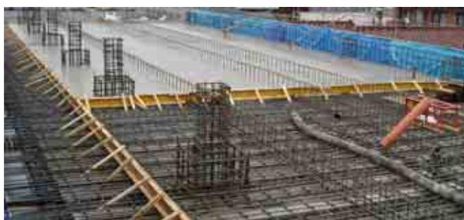
写真4 HPCa スラブ施工状況
