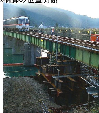
写真-2 仮復旧状況
