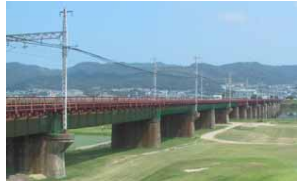
写真-1 橋梁全景
