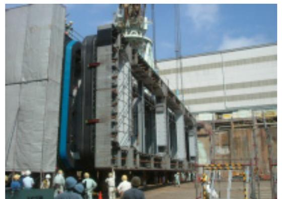
写真-3 クラウンシールブロック建起し状況
