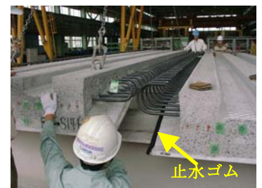
写真-1 床版接合部止水ゴムの性能実証実験
