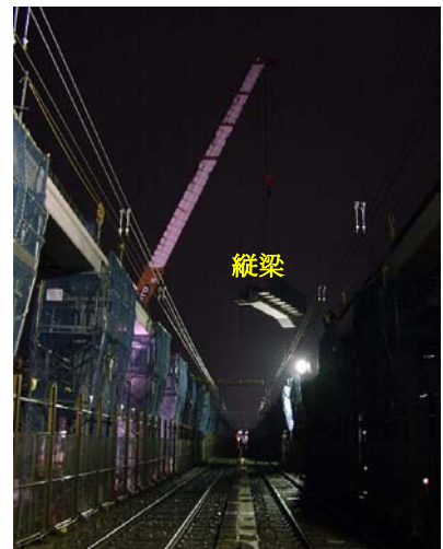
写真-2 縦梁の架設
