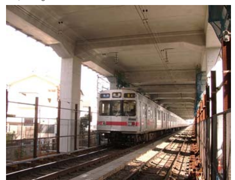
写真-5 躯体構築状況
