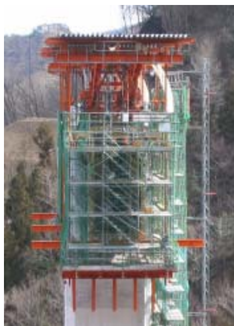
写真-2 ワーゲン組立全景
