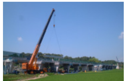
写真 - 1 架設状況
