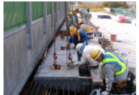
写真 - 3 プレキャスト版架設状況
