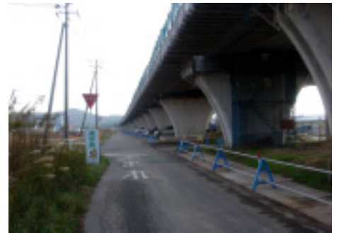
写真 - 2 上部工施工状況
