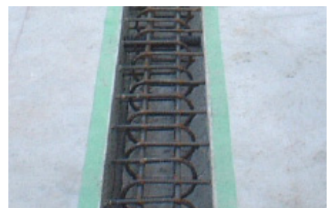
写真 - 4 プレキャスト版接合状況
