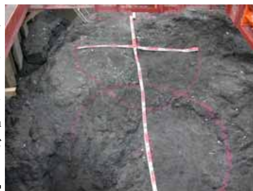
写真-1 改良体の造成状況
