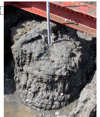
写真-2 改良体の造成状況
